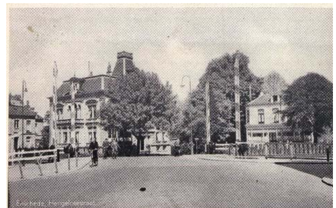
De villa's van Van Heek (links), Ledebouer (midden) en Stroink (rechts), achter de overweg op de Hengelosestraat; ca. 1950
